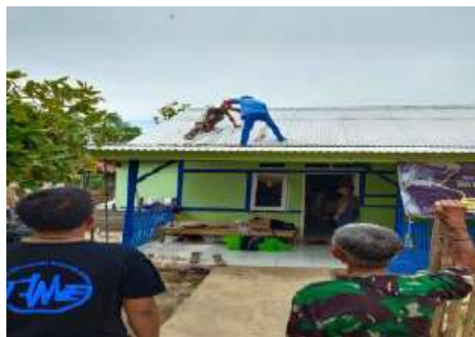
Gambar 1. Pemasangan PLTS Di Rumah Warga
