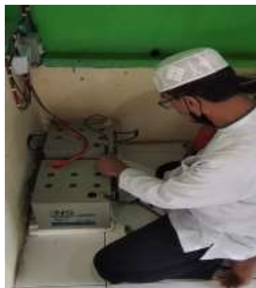
Gambar 5. Pemasangan Baterai baru
