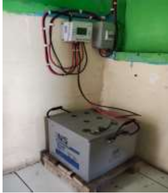
Gambar 4. Kondisi sebelum penambahan Baterai
